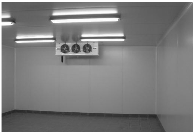
Рисунок 29: Помещение «обшитое» сэндвич-панелями.
